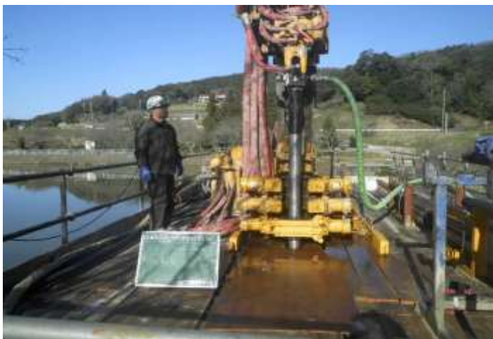
【予備試験アンカー施工の様子】 アンカー孔 削孔
