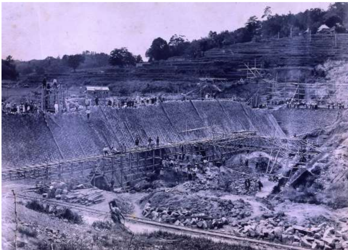
大正 3 年～7 年 忌部千本ダム建設工事
