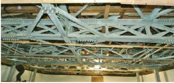
2階展示室天井内の補強平行弦トラス梁
