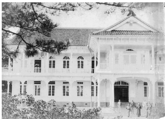
当初竣工(明治36年)
