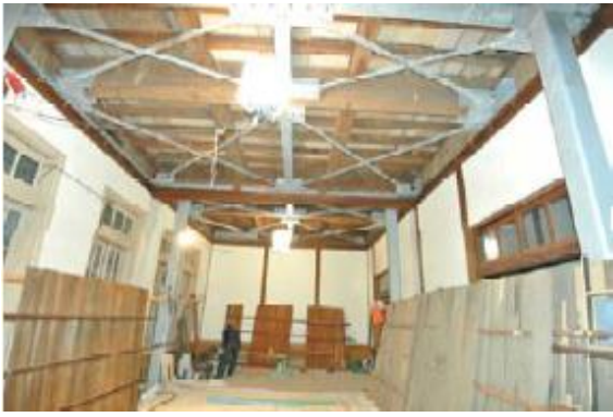
施工時の1階展示室内の鋼管柱と水平構面
