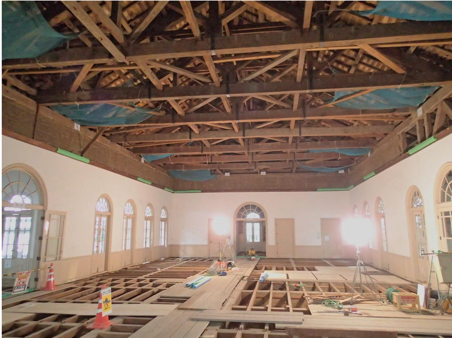
①天井・床解体状況
