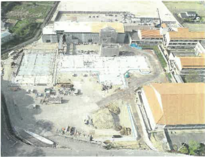
上空より現場全景撮影
